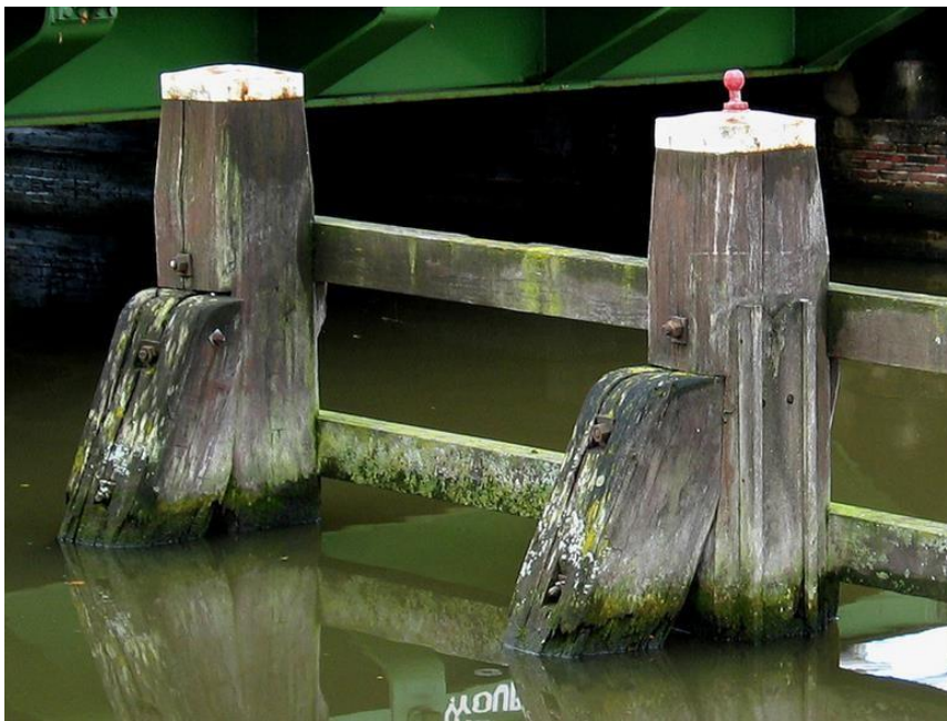
Figuur : geleidewerk bij een brug
